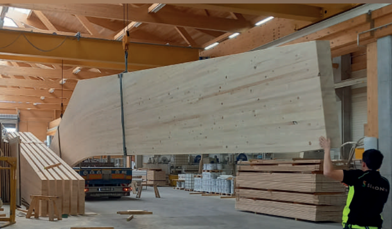
Charpente et structure
